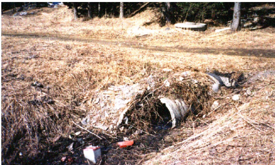
Figura 58. Attualmente la vasca Imhoff è in disuso ed è in stato di degrado.
