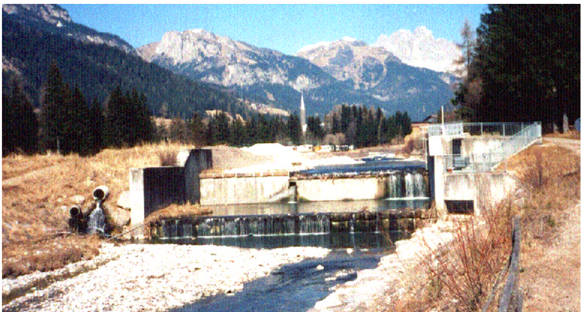
Figura 65. L'opera di derivazione presso Pozza di Fassa, la portata che defluisce sulla destra è dovuta ad un parziale intasamento della griglia.
